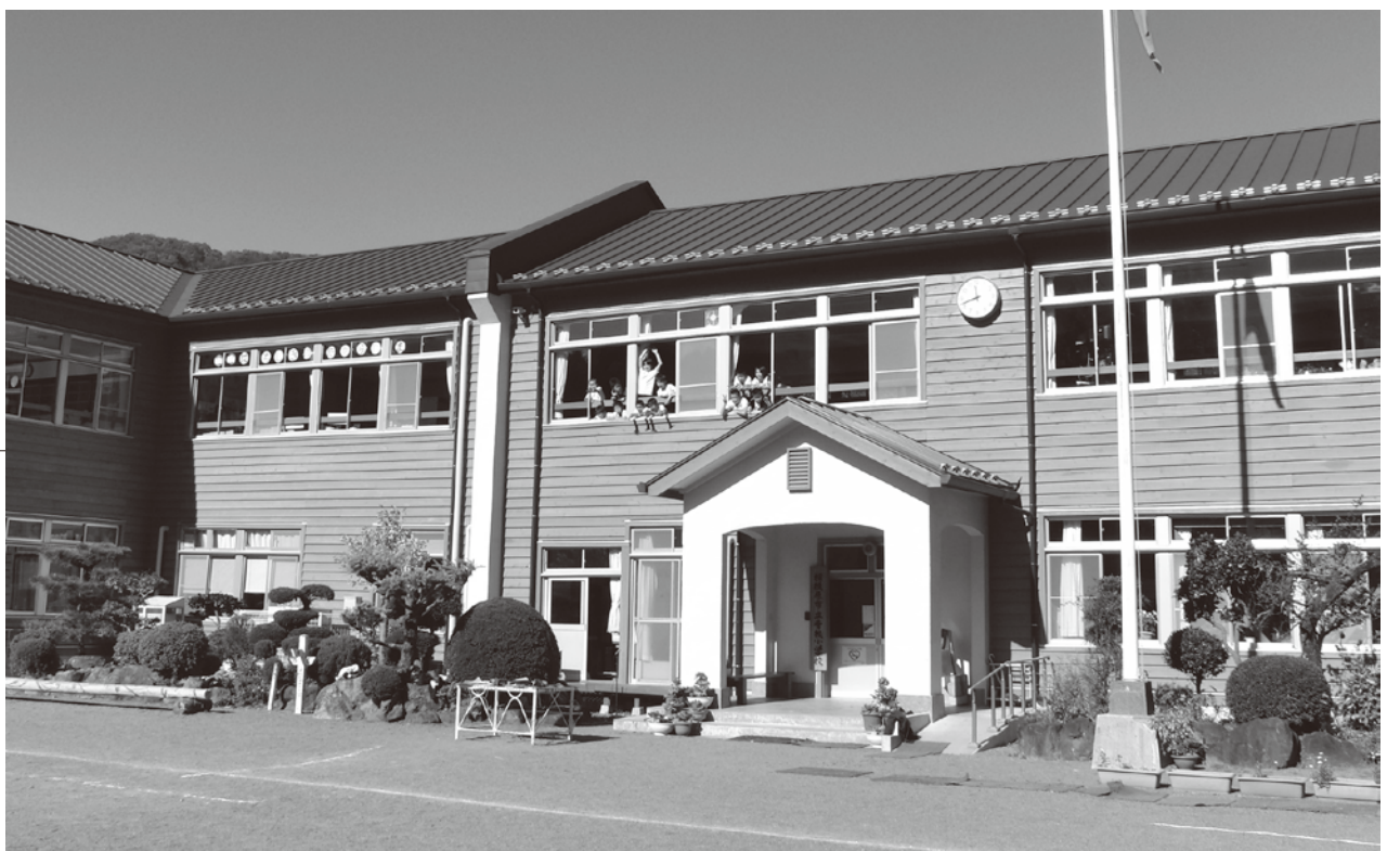
木造校舎(旧青根小学校)
