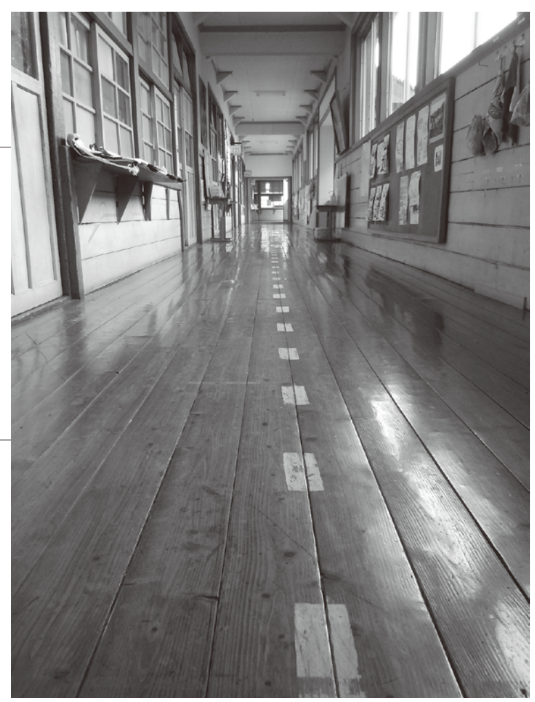
旧青根小学校廊下
