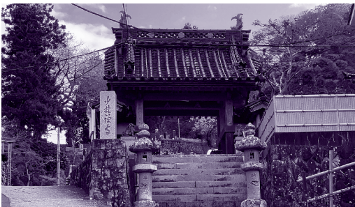
気仙沼駅から近い少林寺。東日本大震災の津波は、石段の下の道にも迫るような勢いだった
